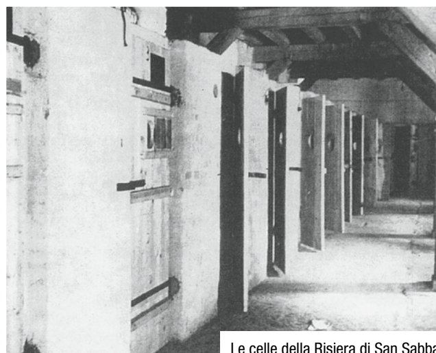
Le celle della Risiera di San Sabba.
